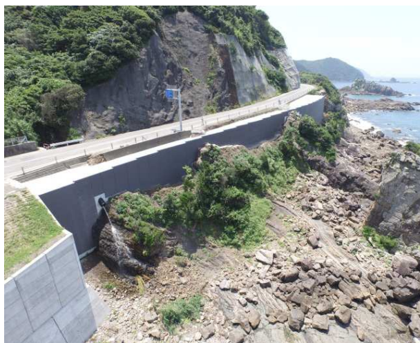
写真-2 調査箇所②施工完了状況
