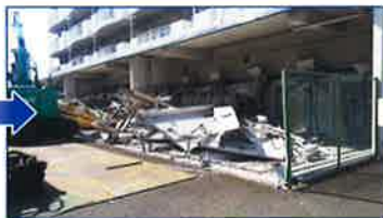
②取り壊し工
