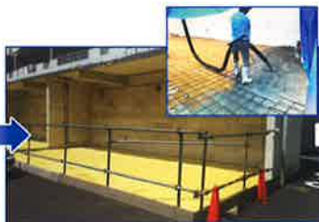
⑤ウレタン完了(コンクリート打設工)
