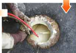
施工状況②
