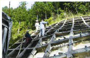
法面充填(法枠裏)
