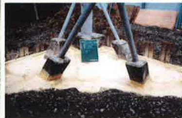
鉄塔塔脚保護
