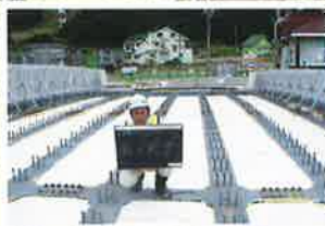
合成床版橋内部充填
