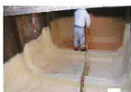
施工前状況①
