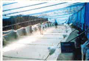
軽量盛土(R-PUR工法)
