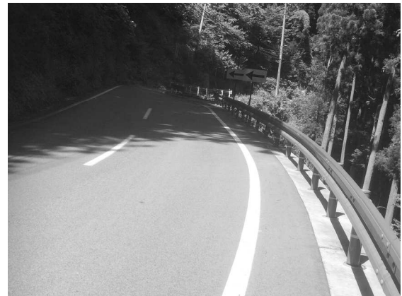
写真-2 路面状況(約950日経過)
