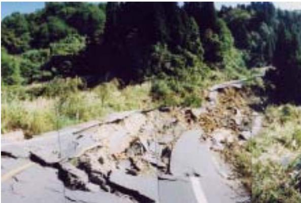
写真 2 土羽打盛土崩壊状況
